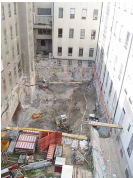
Für die Fundierung der Bauabschnitte - Technikzentrale, Seminarzentrum und Apotheke - des Krankenhauses der Barmherzigen Schwestern Linz wurden von April bis Juli 2010 insgesamt 280 Stück DS-Säulen mit einer Kubatur von rund 1.400 m 3 „gejettet“. In etwa gleicher Menge wurde Rücklaufsusension mittels Schlammulden und Saugwagen zur Entsorgung gebracht
