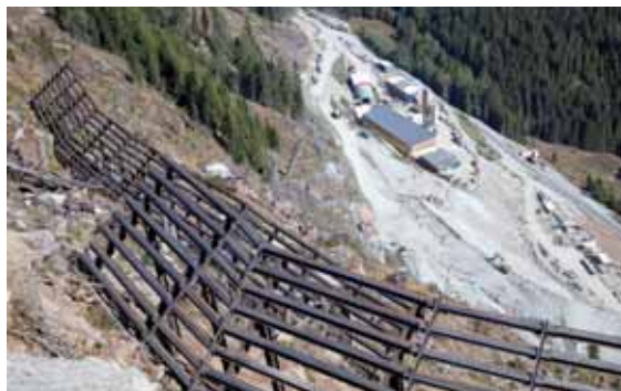
Umfangreiche Felssicherungsarbeiten ermöglichten den rechtzeitigen und weitgehend gefahrlosen Beginn der Bauarbeiten.
