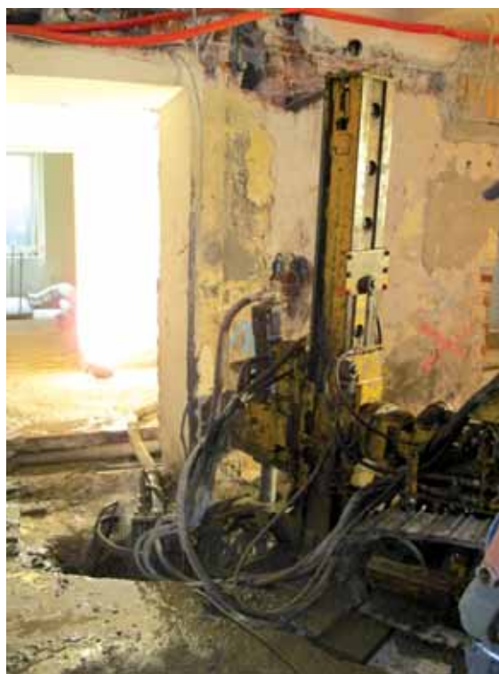
Für die Fundierung der Bauabschnitte - Technikzentrale, Seminarzentrum und Apotheke - des Krankenhauses der Barmherzigen Schwestern Linz wurden von April bis Juli 2010 insgesamt 280 Stück DS-Säulen mit einer Kubatur von rund 1.400 m 3 „gejettet“. In etwa gleicher Menge wurde Rücklaufsusension mittels Schlammulden und Saugwagen zur Entsorgung gebracht
